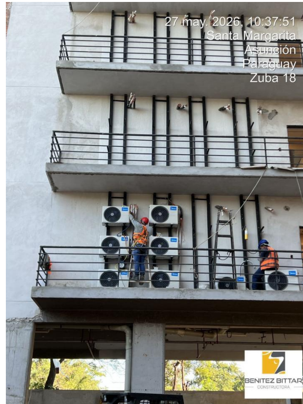
Colocacion de compresores de A.A. – Planta Baja: Base para vereda
